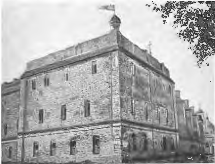
Угловая башня архіерейскаго дома въ Вологодѣ.
